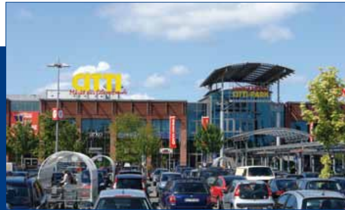
CITTIPark Kiel (der Eingang Blutspende befindet sich links vom Haupteingang)
