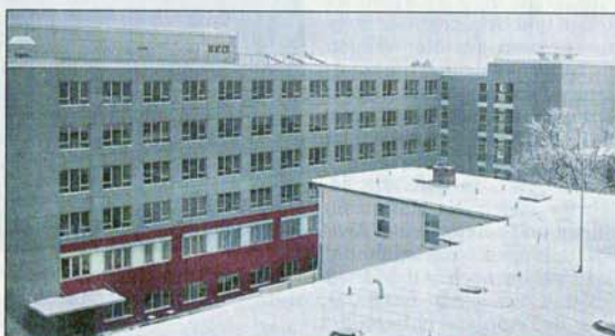
Ursprünglich war das OP-Zentrum nur als Neubau der Operationseinheiten für die ebenfalls direkt angebundene Gynäkologie geplant.
