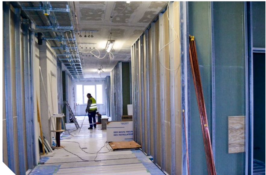
Wände, Kabel, Rohre: Der Innenausbau passt sich den Anforderungen des UKSH an.
