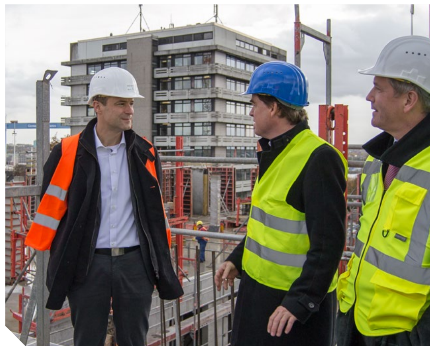
Gesamtprojektleiter der ARGE UKSH Thomas Engelhard beantwortet die Fragen des Bürgermeisters zum Fortschritt auf der Baustelle.
