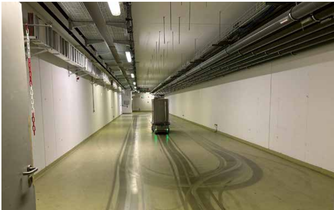
Auf insgesamt 1.400 Metern Länge müssen die SV-Schienen im AWT-Tunnel in Lübeck demontiert und neu verlegt werden.
