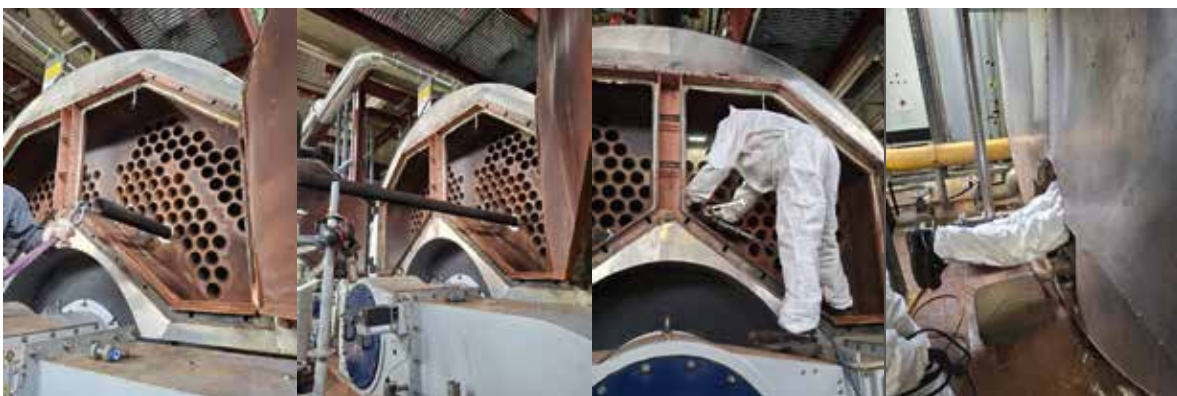
Auftrennen der Nähte und ziehen der defekten Rauchrohre. Dann folgt der Blick ins Innere des Kessels.
